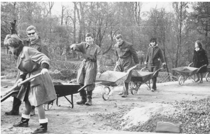
Śluchacze PST przy budowie swojej szkoły
