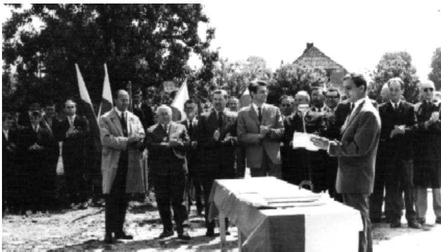
Wmurowanie aktu erekcyjnego szkoły
