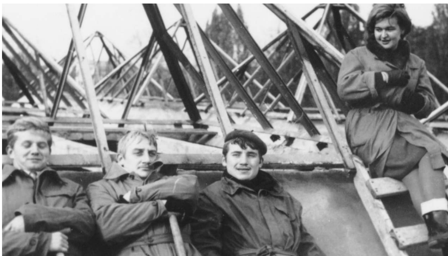
Śluchacze PST w czasie przerwy przy budowie szkoły
